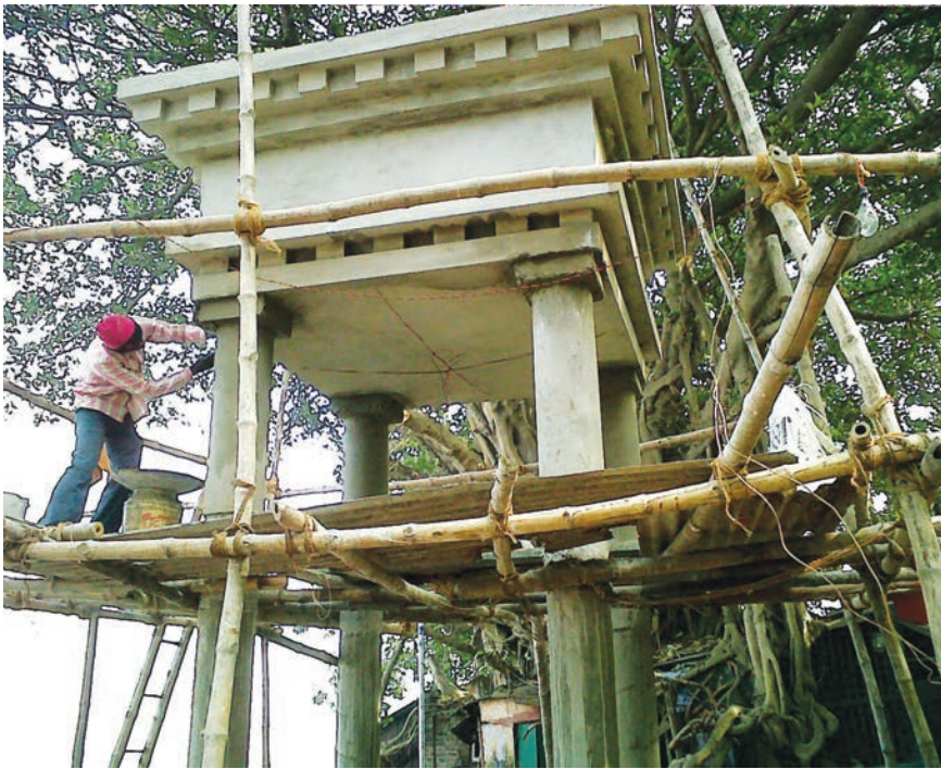
Le Kolkata Memorial en construction, 2010
