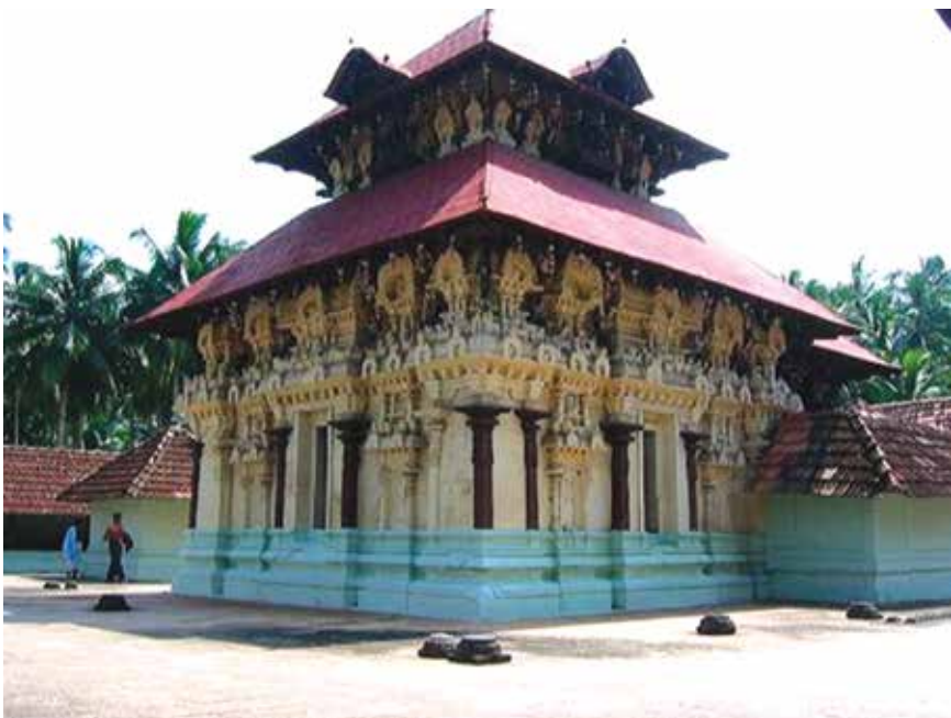
Le passage circumambulatoire, Le temple de Mahadeva à Kazhakuttom, (Source : http://www.vaikhari.org/architecture.html )
